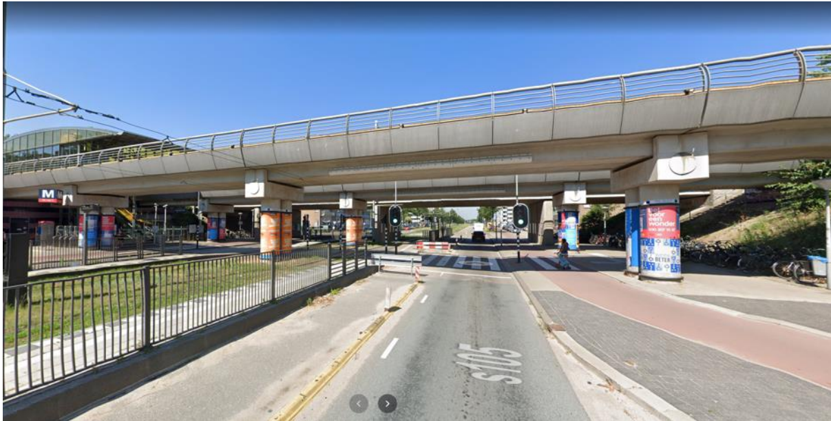
De nu tijdelijk aangelegde versmalling van de rijweg aan de noordzijde biedt de mogelijkheid om de weg te verleggen en meer ruimte te maken voor fietsers en voetgangers
