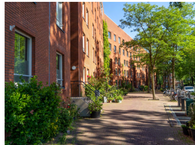
Woningen ontsloten door bords (GWL-terrein)
