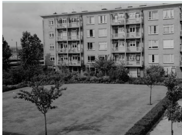
Expressie in gevel door middel van uitkragende balkons (geometrisch gerangschikt), Willem Paaphof (Amsterdam)
