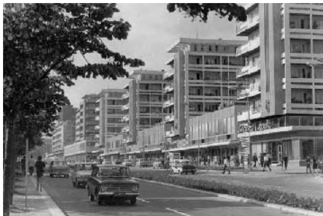
Woningcomplex aan stadslaan, Varna (Bulgarije)
