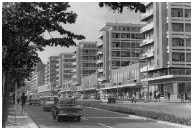
Woningcomplex aan stadslaan, Varna (Bulgarije)
